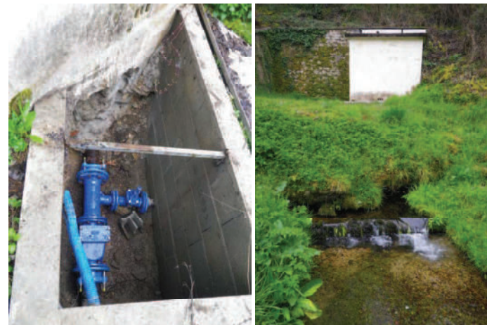
Figure 4 : exutoire de la source (photos)
